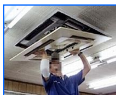
② 解体作業
