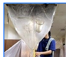
④ エアコン内部洗浄
