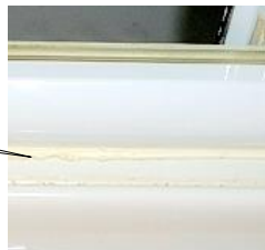
掃除前(浴室入口)
