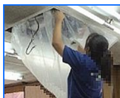
⑥ 洗浄カバー取り外し
