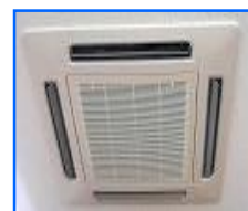
⑧ 床面及び周辺の養生を取り外し、原状復帰
